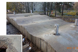
Kiinnitysrakenteet. Naaraspuolella käytetty mustaa rautaa joka on lähes kokonaan ruostunut kadoksiin.
